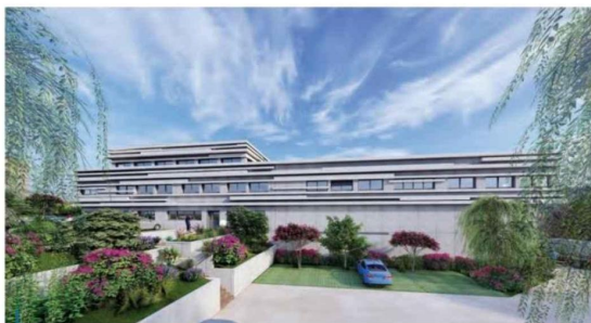
Posé sur un socle qui accueillera la zone fabrication d'Omex, le bâtiment se déploie sur deux niveaux et un important rooftop.
