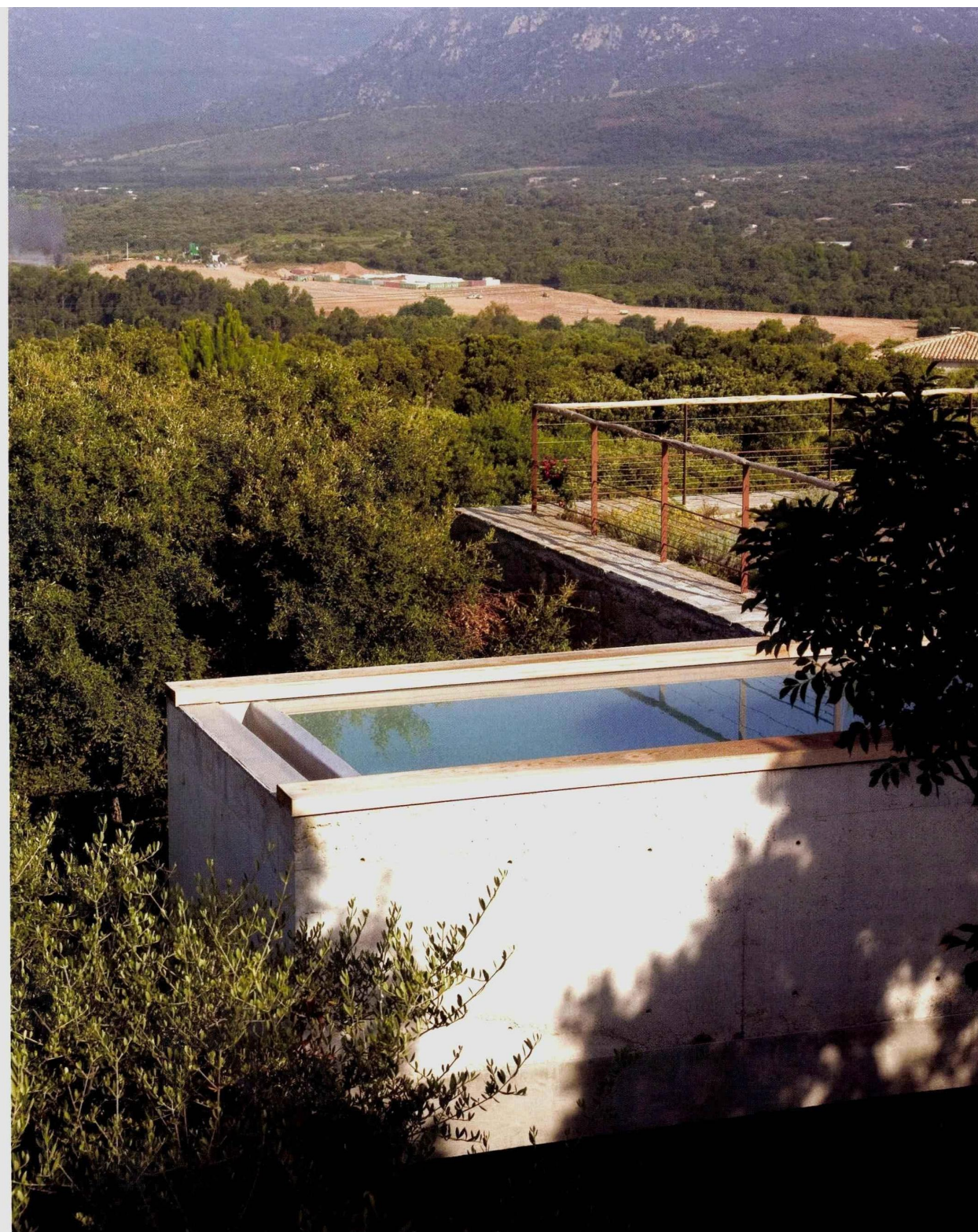
Le bassin est construit au-dessus du terrain de façon à préserver la nature environnante et à minimiser son emprise au sol. Villa Santa-Lucia, à Porto-Vecchio (20), Corinne Vezzoni & Associés. © Patrice Terraz
